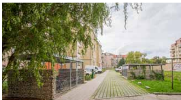
Przepuszczalne powierzchnie na parkingach i drogach osiedlowych retencjonują wodę.
